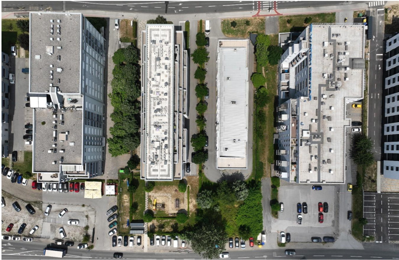
Sl. 22. Zbijene zgrade na Jaruščici
