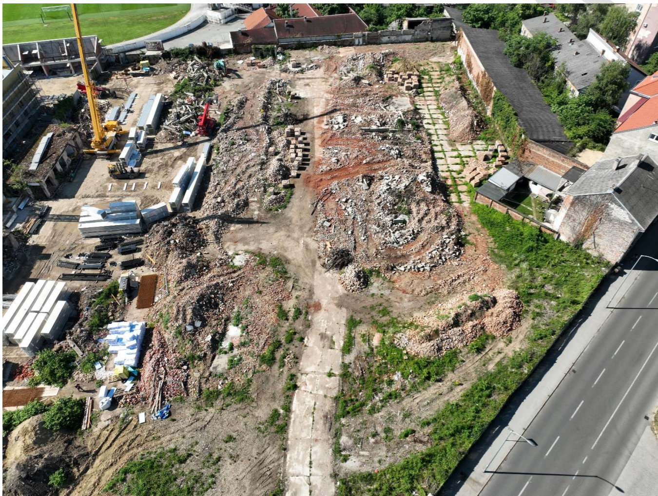
Sl. 80. Kompleks Bubara u postupku uklanjanja vegetacije i derutnih građevina
